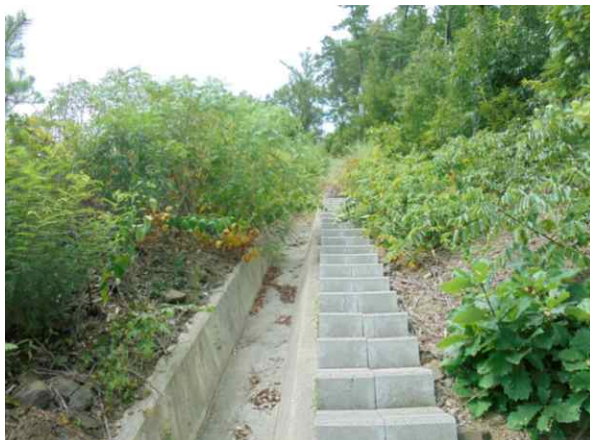
점점계단, 산마루측구 전경
