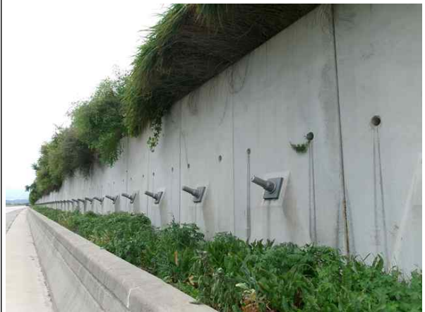
사면내 옹벽 전경
