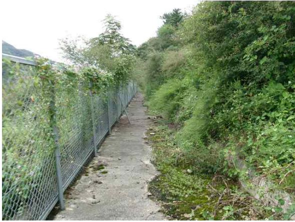
1소단 배수로 전경
