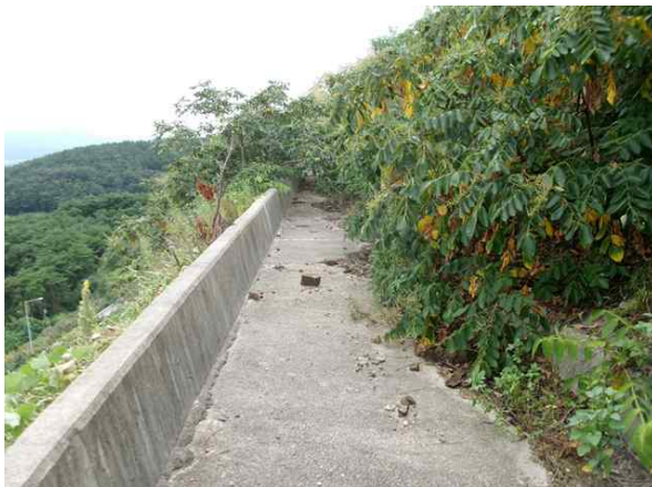
2소단 배수로 전경
