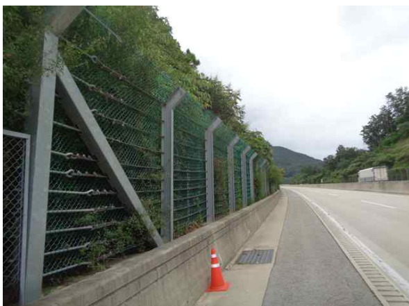
하부, 낙석방지울타리 전경
