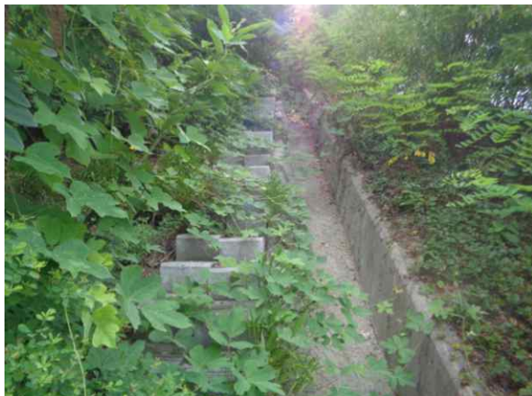
산마루측구, 점검계단 전경
