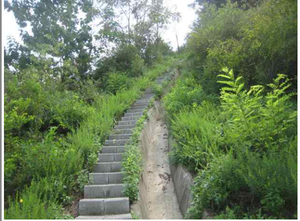
점검계단, 산마루측구 전경
