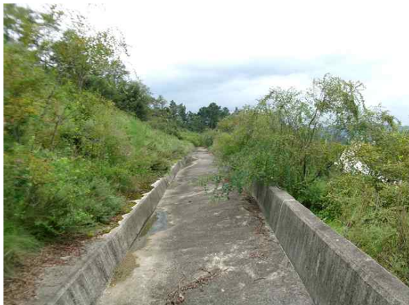
1소단 배수로 전경
