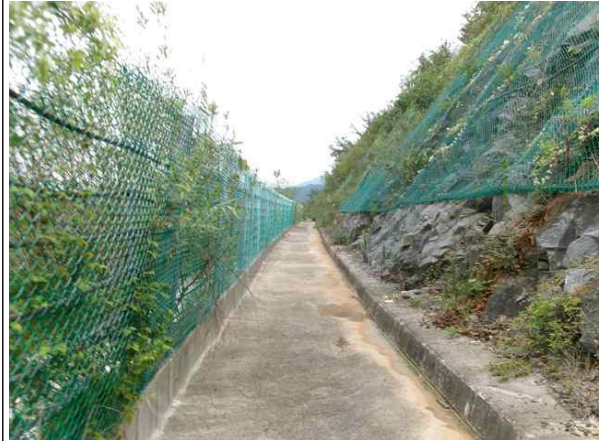
소단배수로 낙석방지울타리 전경
