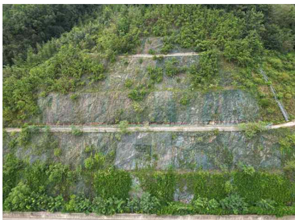
낙석방지망, 사면부 전경
