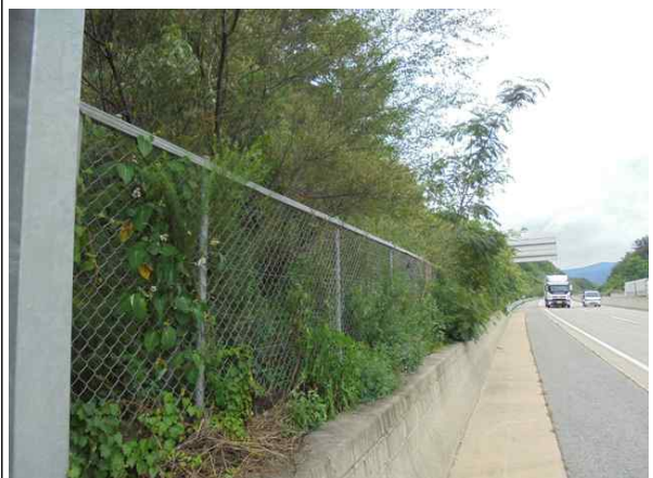
도로, 야생동물유도울타리 전경
