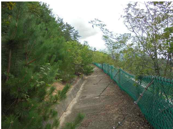
1소단 배수로 전경
