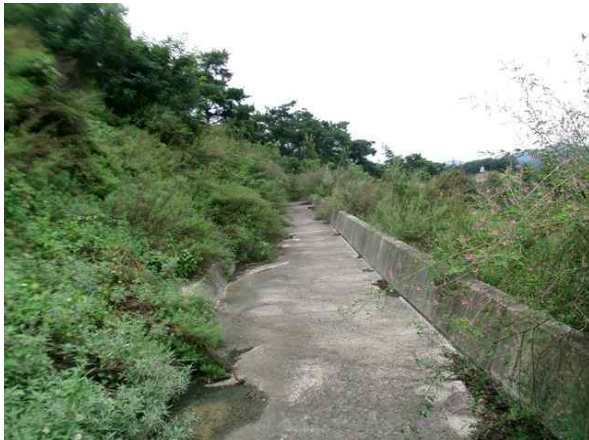
1소단 배수로 전경
