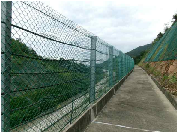
소단배수로 낙석방지울타리 전경
