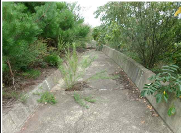
1소단 배수로 전경
