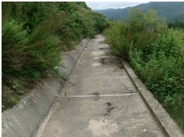
1소단 배수로 전경
