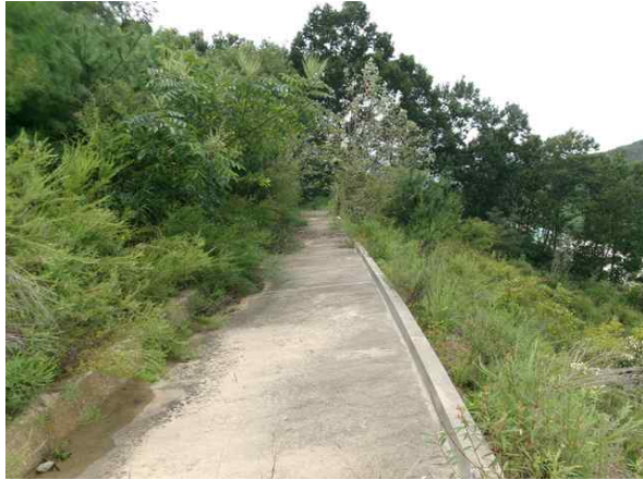
1소단 배수로 전경
