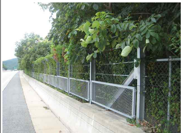
하단, 낙석방지울타리 전경
