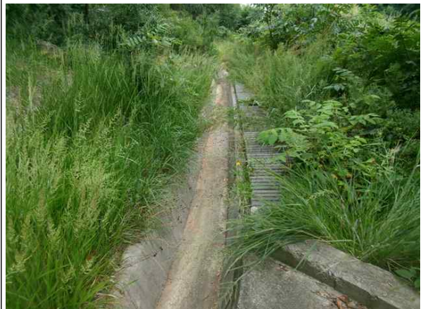
산마루측구, 점검계단 전경
