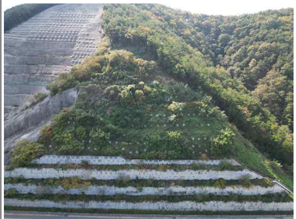
사면내 옹벽(패널식옹벽05) 전경
