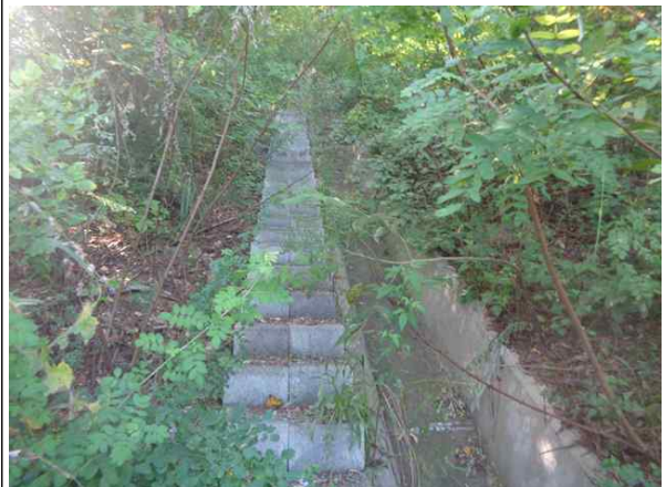
산마루측구, 점검계단 전경
