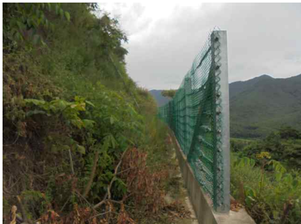
소단배수로, 낙석방지울타리 전경
