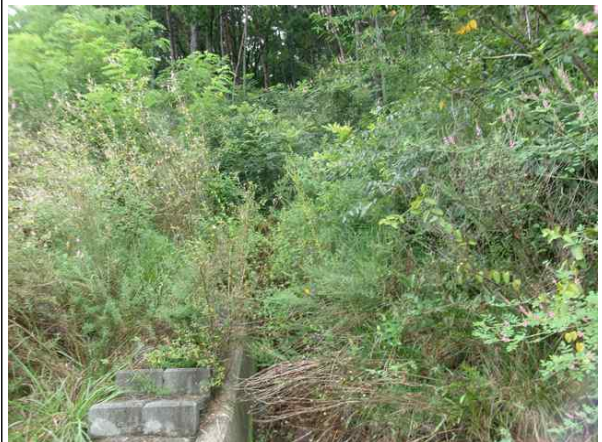
산마루측구, 점검계단 전경
