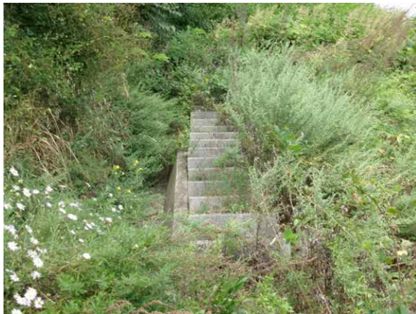
산마루측구, 점검계단 전경
