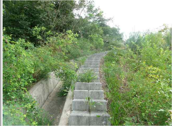
산마루측구, 점검계단 전경
