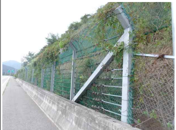
도로, 낙석방지울타리 전경
