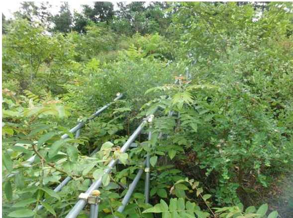
2단 점검계단 전경
