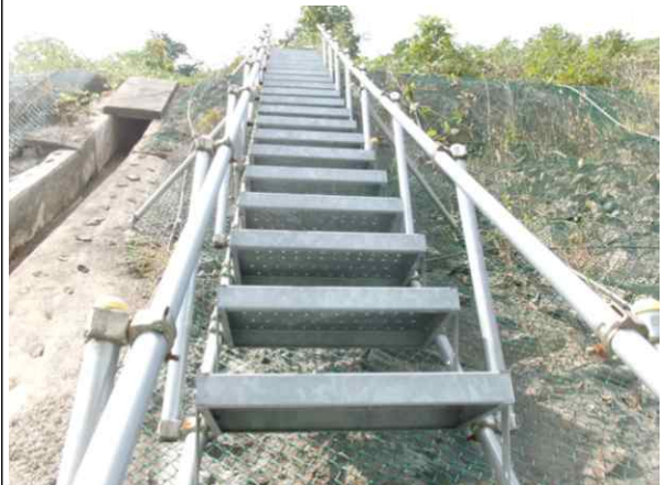
수직도수로, 점검계단 전경
