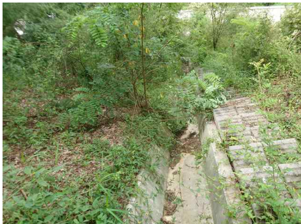
점검계단, 산마루측구 전경
