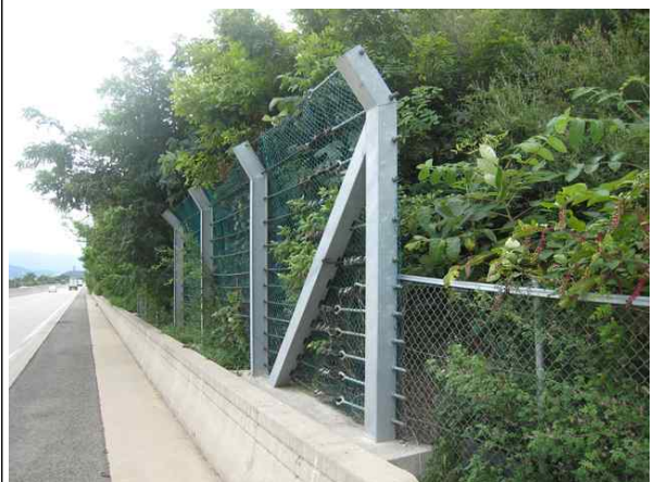
하단 낙석방지울타리 전경
