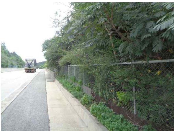
도로, 야생동물유도울타리 전경
