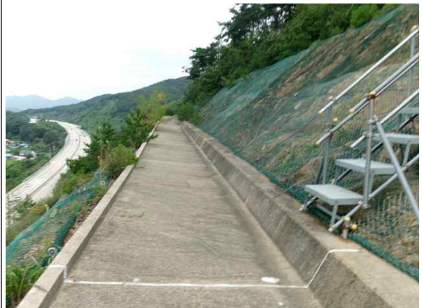
2소단 배수로 전경
