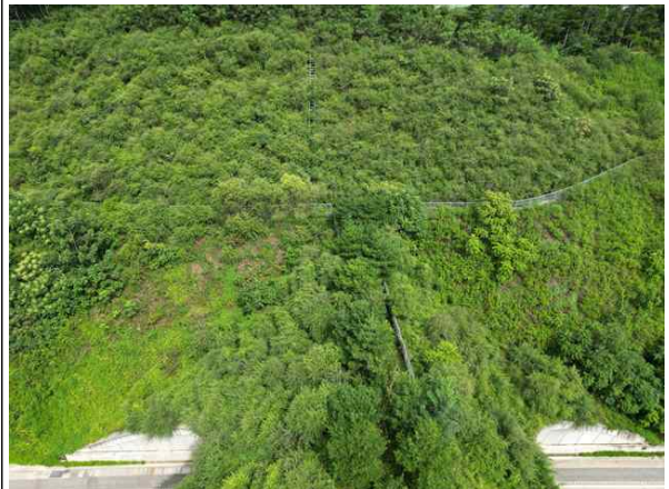
상태육교 상부 전경
