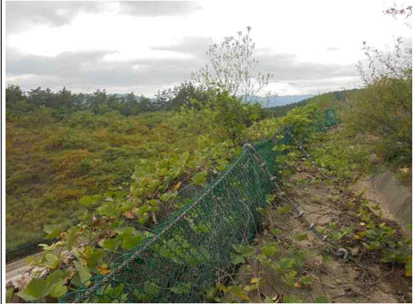
1소단 배수로 전경
