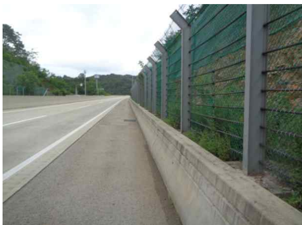
도로, 낙석방지울타리 전경
