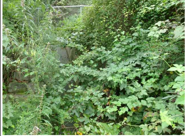
산마루측구, 점검계단 전경
