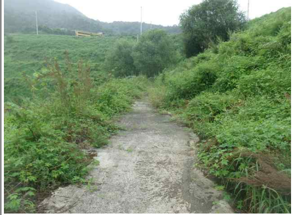
1소단 배수로 전경
