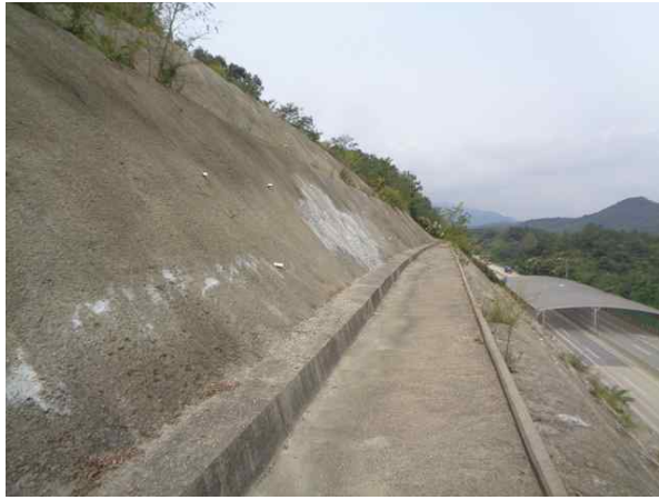
1소단 배수로 전경
