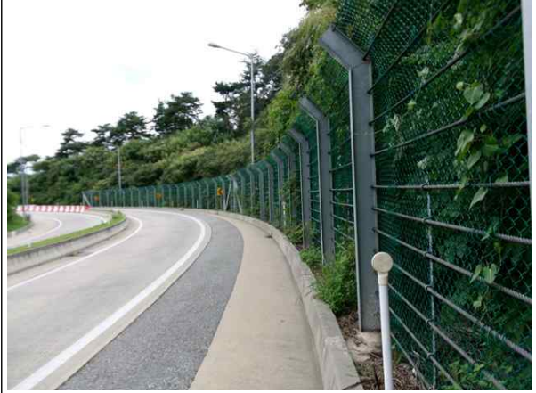
도로, 낙석방지울타리 전경
