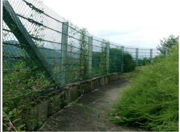
2소단 배수로 전경
