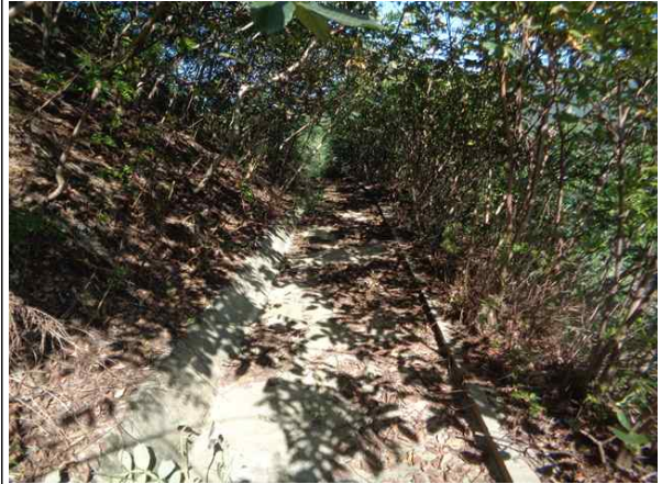
1소단 배수로 전경
