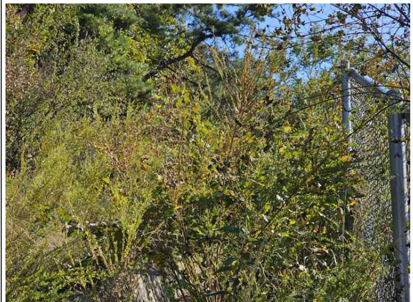
산마루측구, 점검계단 전경
