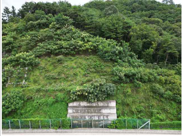
사면내 옹벽 전경
