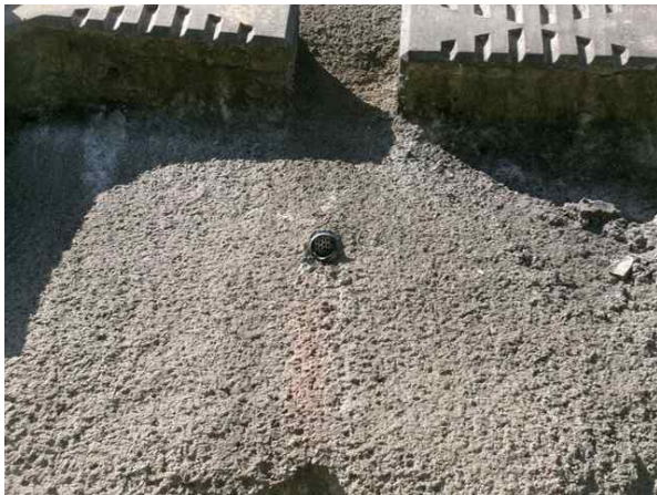
앵커부 수평배수공 전경
