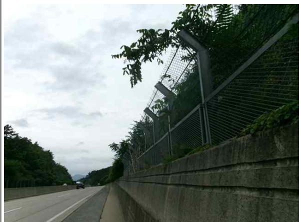
도로, 낙석방지울타리 전경
