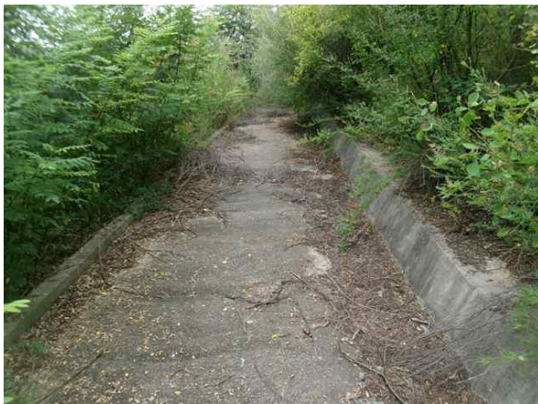
1소단 배수로 전경
