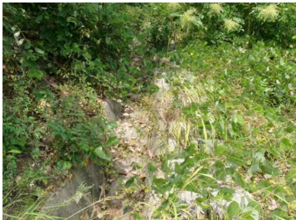
산마루측구, 점검계단 전경
