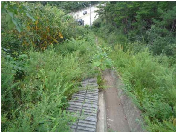
산마루측구, 점검계단 전경
