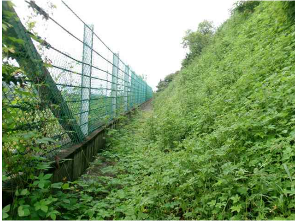
1소단 배수로 전경
