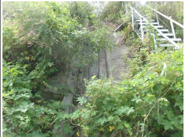
수직도수로, 점검계단 전경
