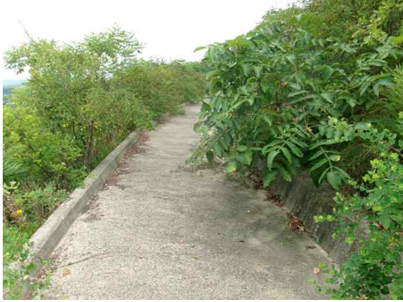
1소단 배수로 전경
