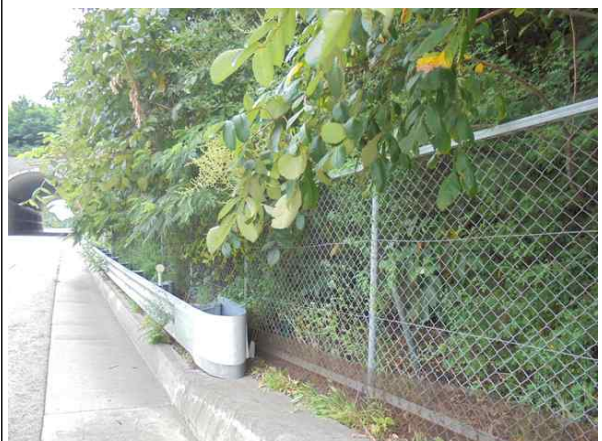
도로, 야생동물유도울타리 전경
