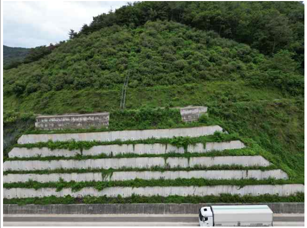
사면내 옹벽 전경
