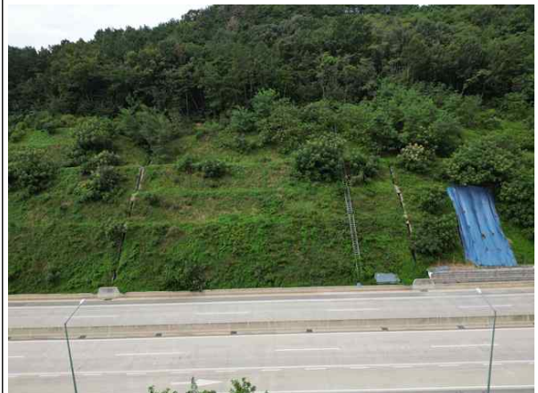
점검계단, 수직도수로 전경
