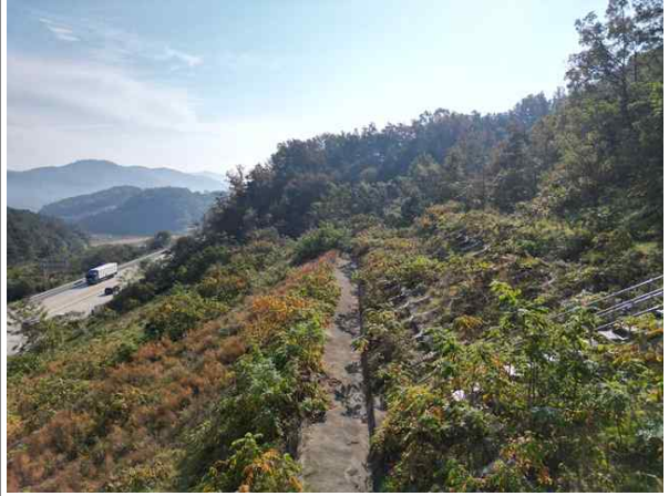
1소단 배수로 전경
