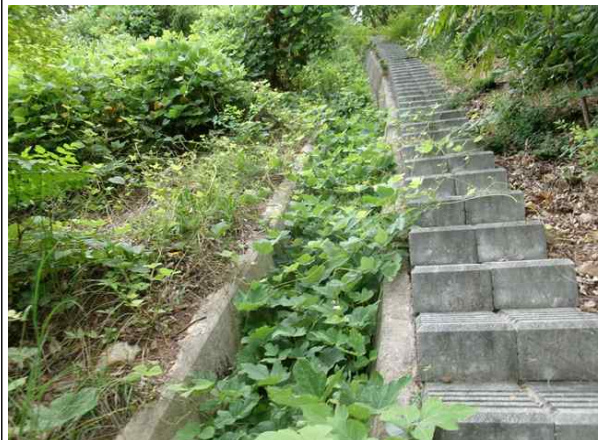
점검계단, 산마루측구 전경
