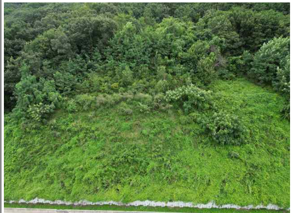
사면부, 하단 판넬형옹벽 전경
