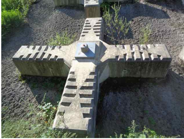
쏫크리트, 격자앵커 전경
