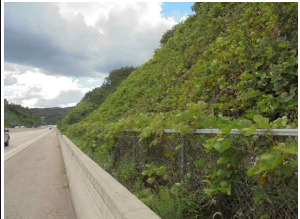
도로, 야생동물유도울타리 전경
